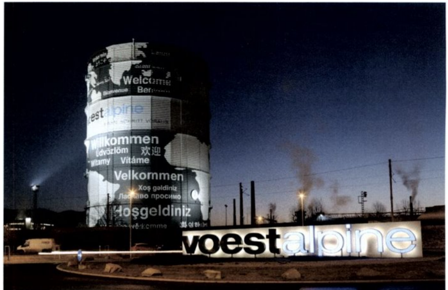
Grüner Wasserstoff. Im Projekt H2FUTURE arbeitet VERBUND mit voestalpine an der Energiezukunft
