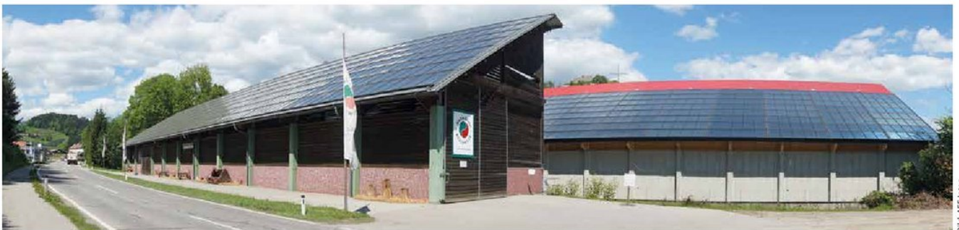
Solare Einspeisung in das Wärmenetz von Eibiswald. Bestand: 1.250 m 2 Flachkollektoren. Neubau: 1.200 m 2 Flachkollektoren.
