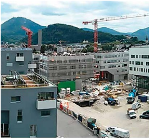
Blick auf die Dächer des Stadtteils Lehen, Salzburg. Hier wurden Wärmepumpen gut mit Solarthermie kombiniert. Zum Einsatz kommt eine speichergekoppelte Wärmepumpe (160 kW), deren Verdampferenergie ausschließlich durch den Pufferspeicher bereitgestellt wird.
