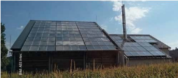
Solare Einspeisung in das kommunale Nahwärmenetz von Großklein mit rund 350 m 2 Flachkollektoren.
