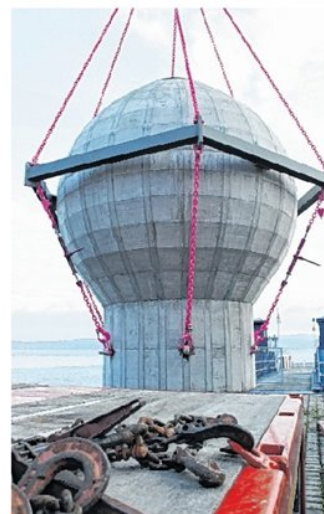
Das Konzept zeigt Betonkugeln (l.), die unter Wasser Energie speichern sollen. Morgen wird so eine Kugel (r.) in den Bodensee abgelassen. Foto: Fraunhofer IWES
