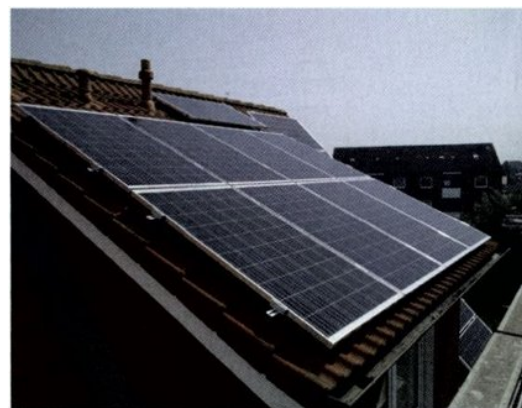
PV-Installation für 40 Eigenheime auf der Insel Borkum
